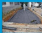
透水シート施設
