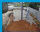
客土投入敷均し
